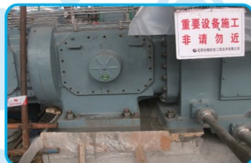
岳阳长岭石化项目
