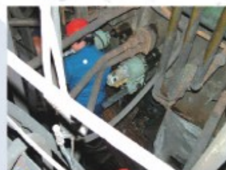
棒式冷却器炉皮钻孔 (植入冷却棒)
