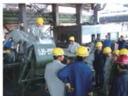
材料混练 (高炉压入用)
